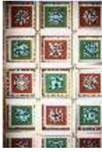
Aschpomp.II, Decke im Atrium, R. 2, DI024782, BSV-
