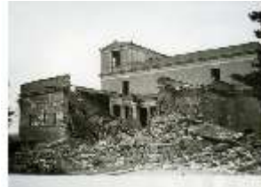
AschPomp.I, zerstörte Atriumstrakt, Ende 1944, DE003660, BSV-
