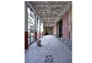
AschPomp.II, Peristylum, Säulenhalle (R. 16), DI015015, BSV-
