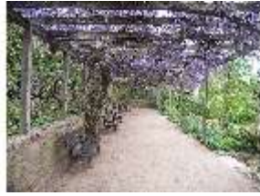
Aschpomp.V, Pergola, DI022672, BSV-
