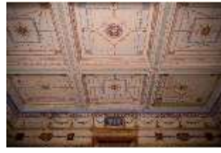
Aschpomp.II, Decke im Cubiculum, R. 31, DI024804, BSV-
