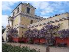
Aschpomp.I, Fassade von Süden, DI022671, BSV-
