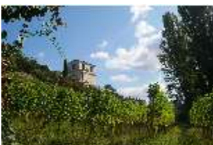
AschPomp.V, Blick über die Weinstöcke zur Südfassade, DI013979, BSV-
