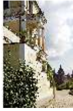
AschPomp.I, Freitreppe mit Agaven, DI014972, BSV-
