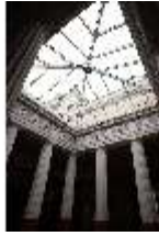
AschPomp.II, Atrium Glaspyramidendach, R. 2, DI024752, BSV-
