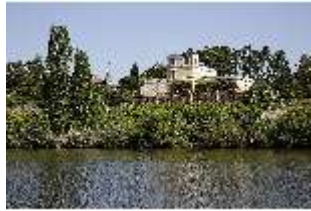
AschPomp.I, Südfassade vom Main aus, DI014981, BSV-
