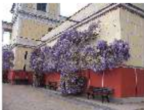
Aschpomp.I, Fassade von Süden, DI022670, BSV-
